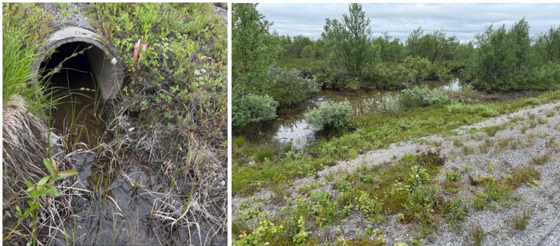
Figur 5-3. Krysning 2. Venstre: Innløpsarrangement ved 450 mm stikk under rv. 92. Høyre: Nedstrøms utløpet.
