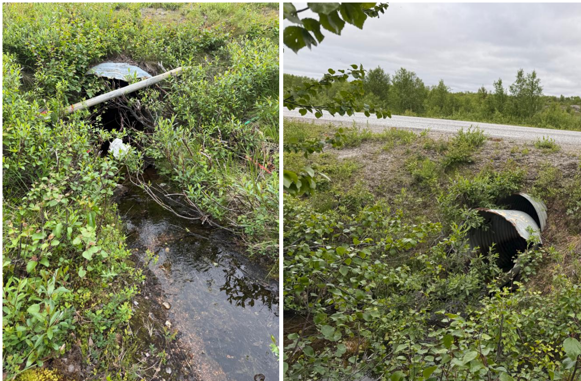
Figur 5-4. Krysning 3. Venstre: Innløpsarrangement ved Ø1200 mm stikk under rv. 92. Høyre: Stikkrennens utløpsarrangement.
