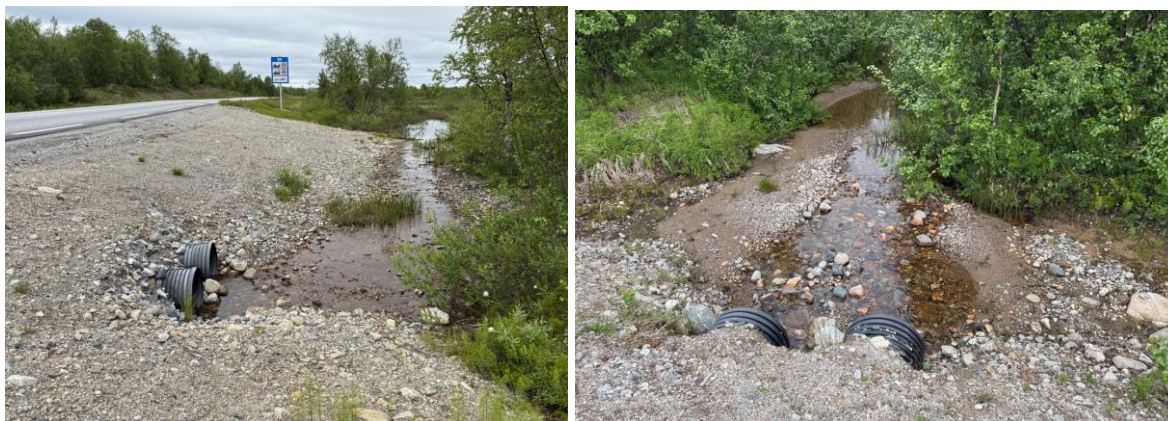
Figur 5-2. Krysning 1. Venstre: Innløpsarrangement ved 2x450 mm stikk under rv. 92. Høyre: Stikkrennenes utløpsarrangement.
